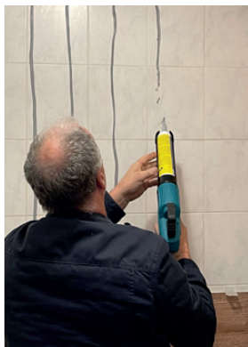
Szybka metamorfoza łazienki z użyciem klejów hybrydowych WIM STRONG nanoszonych na istniejącą okładzinę z płytek
