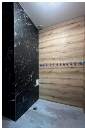
Efekt końcowy metamorfozy łazienki z przyklejonymi płytami SPC przed montażem ceramiki sanitarnej
