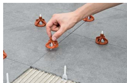
Fot. 14. System RLS VITE do poziomowania płyt
