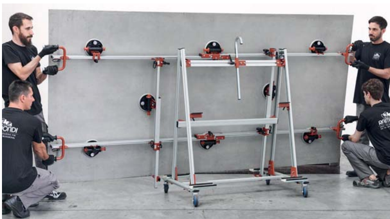
Fot. 4. Połączenie przyssawek za pomocą ramy
