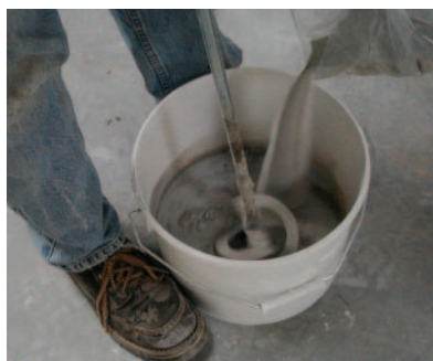
Fot. 3. Łączenie wypełniacza z żywicą
