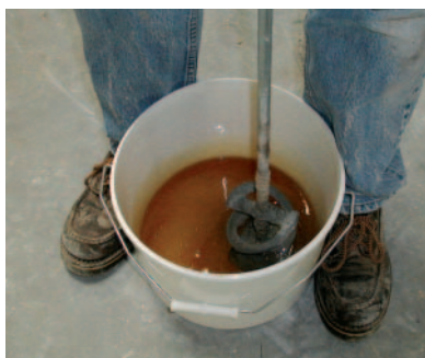
Fot. 2. Mieszanie utwardzacza z żywicą reaktywną
