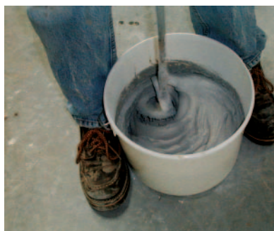
Fot. 4. Wymieszana gotowa do użycia fuga – klej mira 3650 multipox
