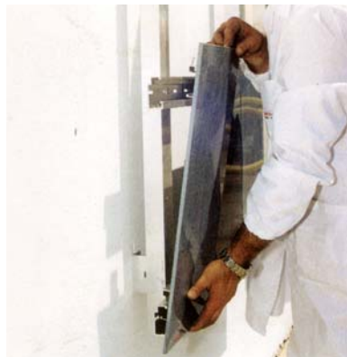
Fot. 4. Montowanie płyty z osadzonymi w niej samoklinującymi się łącznikami
