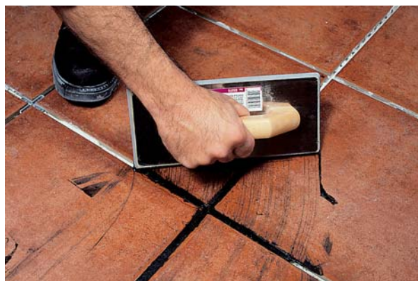
Spoinowanie płytek ceramicznych za pomocą gumowej pacy
