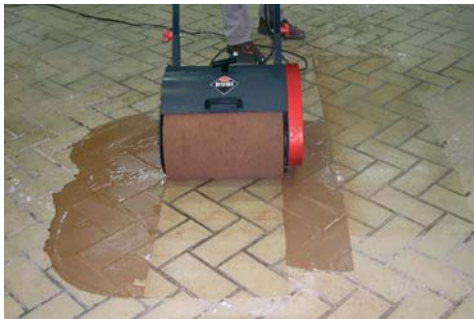
Spomatic – urządzenie do czyszczenia i profilowania spoin okładzin
