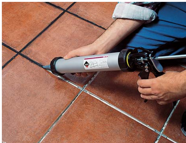
Aplikator umożliwia dokładne umieszczanie zapraw w spoinie
