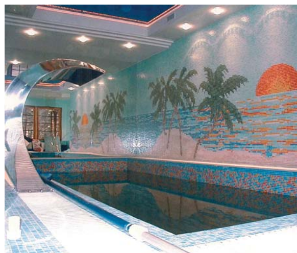
Fot. 2. Szklana mozaika 10 x 10 mm zastosowana na okładzinę prywatnego basenu
