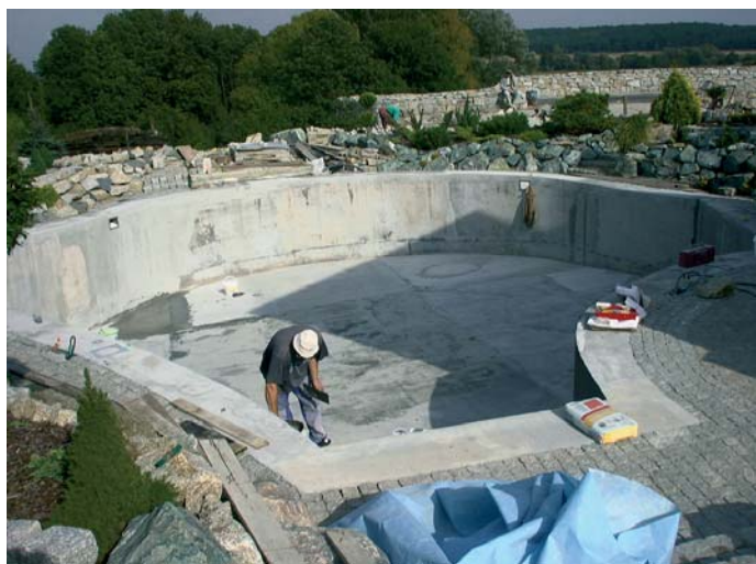
Fot. 1. Skomplikowana forma niecki basenowej wymagająca zastosowania mozaiki
