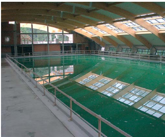
Fot. 3. Próba wodna na jednym z basenów
