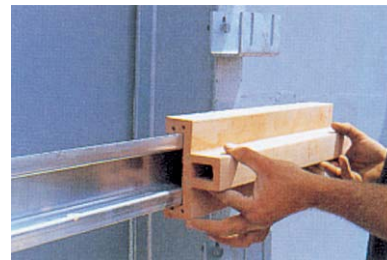
Fot. 5. Kształtki cotto nasuwane są na stalowy stelaż
