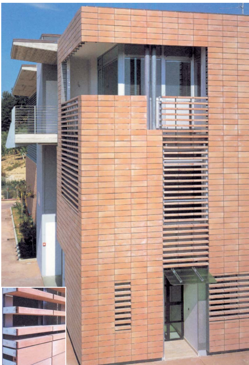
Fot. 2. Budynek w Teramo z elewacją z płyt cotto 50x14,5x5 cm
