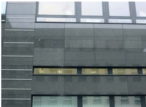
Przykład elewacji z kamienia mocowanego w sposób mechaniczny
