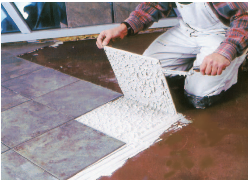
Kleje półpłynne mira 3150 planfix oraz mira 3250 superplanfix idealnie pokrywają całe podłoże, co eliminuje powstawanie pustek pod płytką
