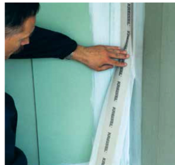
Wklejanie taśmy uszczelniającej w narożu
